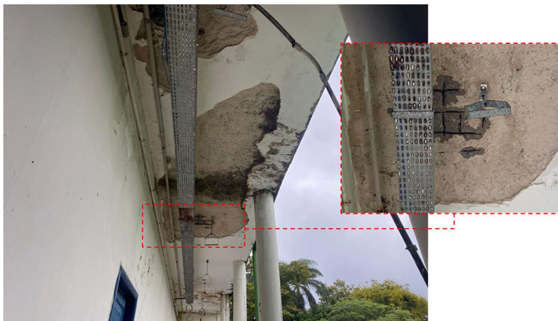
Figura 10 – Manifestações patológicas em laje sobre circulação aberta;
